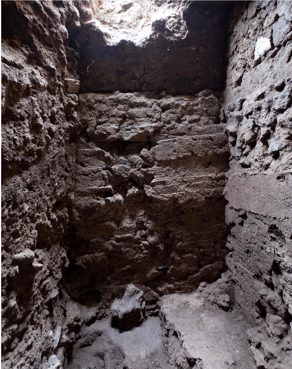
Fig. 4 - Pompéi. Vue de l'un des caissons de la structure du podium du temple après enlèvement des échafaudages destinés à la sécurisation du sondage.
